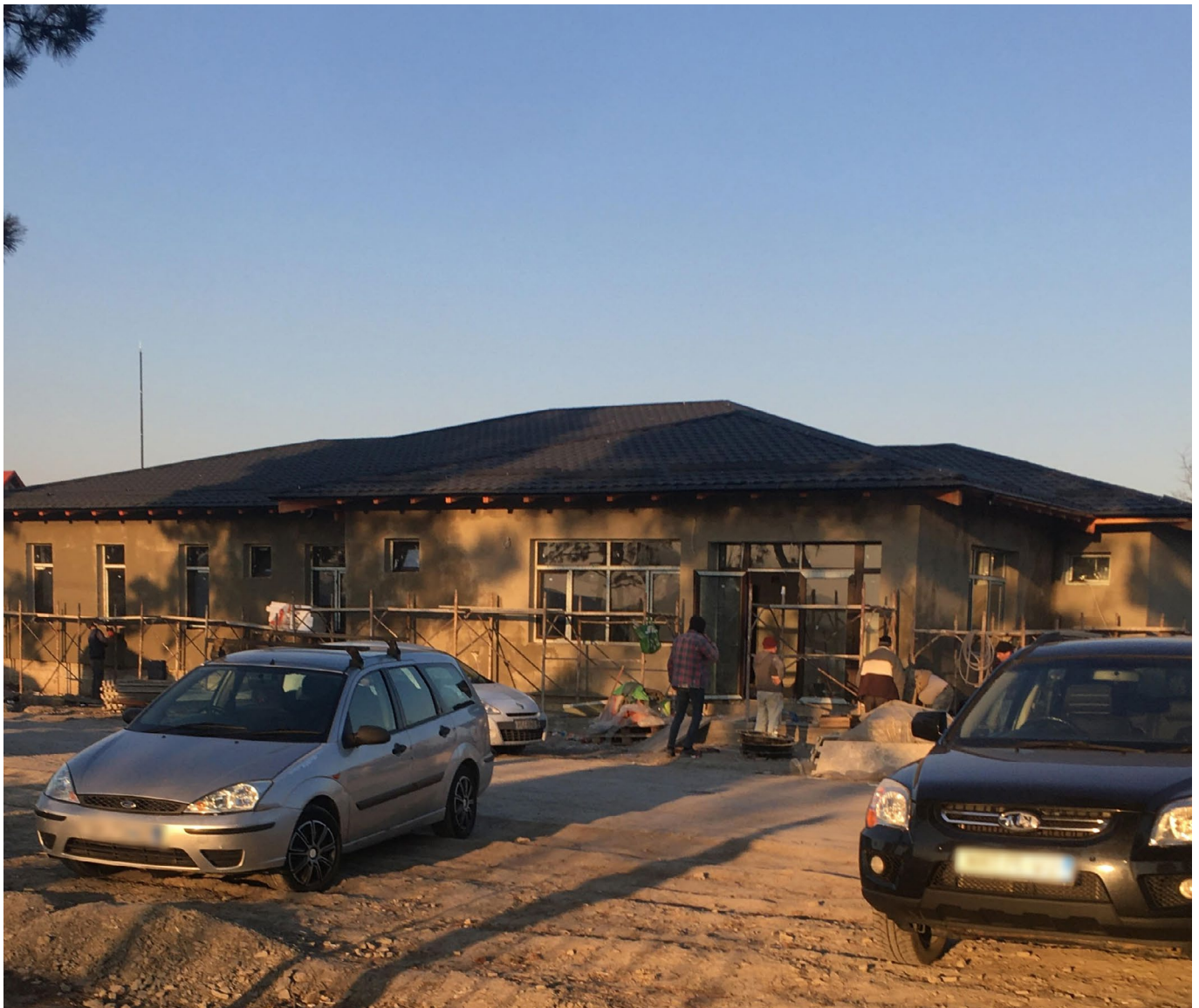
Ανακατασκευή παλιάς αποθήκης σε κέντρο υπηρεσιών για πρόσφυγες στο Σιρέτ της Ρουμανίας. 23/04/2022
